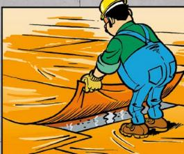
Zakryj beton rohožemi nebo pásy fólie, ujistě se, že mají dostatečné přesahy, zajistit je proti nadzvednutí větrům.
