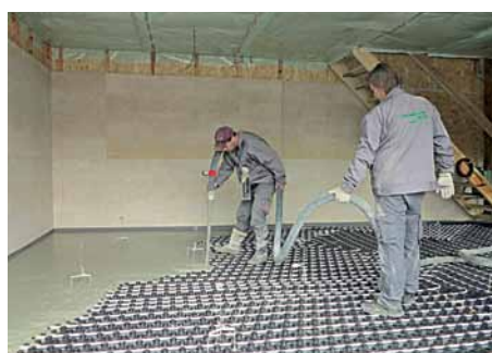
8. Aplikace litého cementového potěru CEMFLOW
