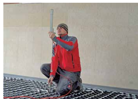
3. Nastavení výšky litého potěru pomocí trojnožek nad předem položené části podlahového souvrství
