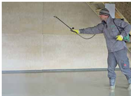
11. Ošetřování litého cementového potěru CEMFLOW po zpracování
