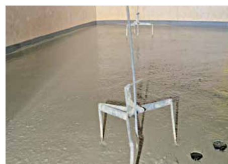
9. Litý potěr CEMLOW po aplikaci před nivelací
