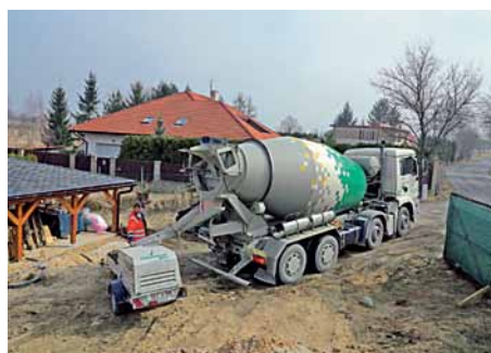
5. Příjezd techniky a materiálu pro čerpání na stavbu
