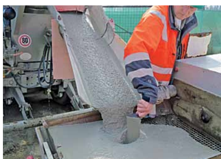
7. Čerpání lité směsi na stavbě z autodomíchávače
