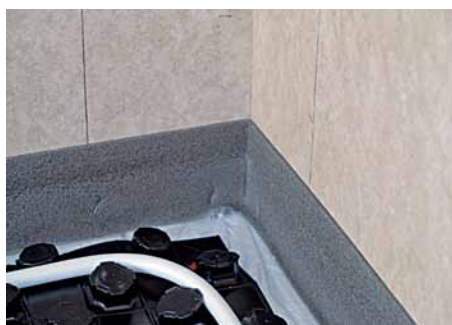
1. Příprava podlahového systému s teplovodním vytápěním k aplikaci litého potěru
