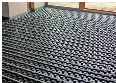
2. Prostory s podlahovým topením připravené k lití potěru
