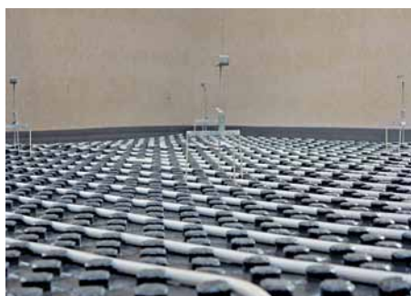
4. Ideálně připravený prostor pro pokládku litého potěru
