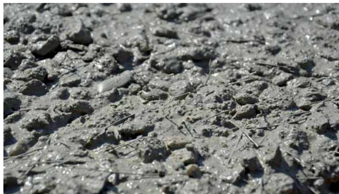
10:30 hod. – na stavbě: STEELCRETE® – detail čerstvého betonu po čerpání na plochu základové desky
