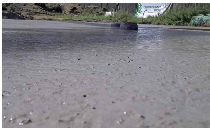
11:15 hod. – Na stavbě: STEELCRETE® – detail zpracovaného betonu do požadované roviny základové desky.
