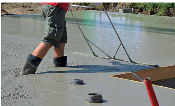
10:45 hod. – na stavbě: STEELCRETE® – zpracování základové desky do požadované roviny
