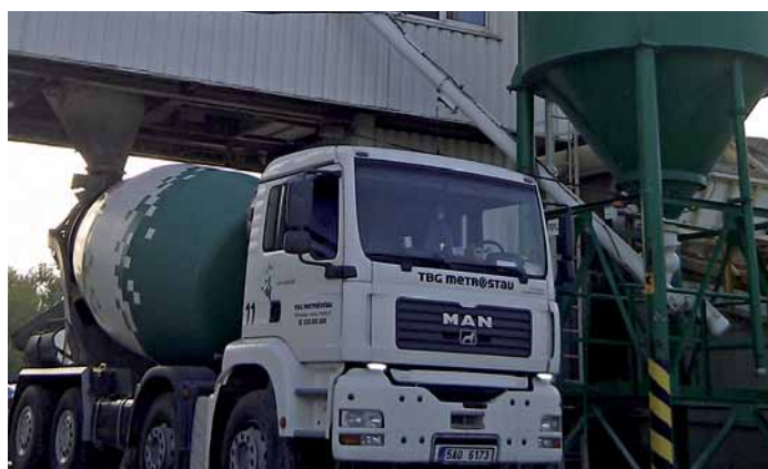
8:30 hod. – v betonárně: Začíná se míchat drátkobeton STEELCRETE® podle zvolené receptury
