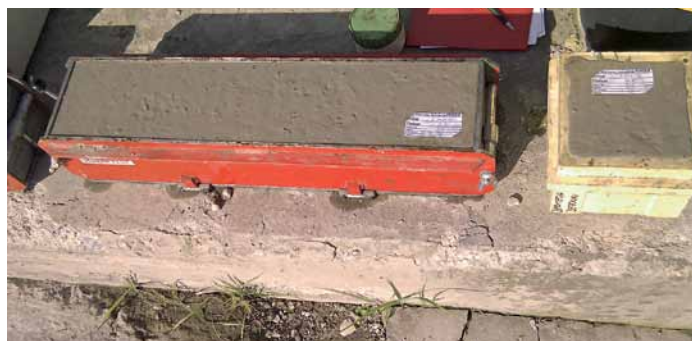
8:50 hod. – v betonárně: STEELCRETE® – odběr vzorků na kontrolní testy
