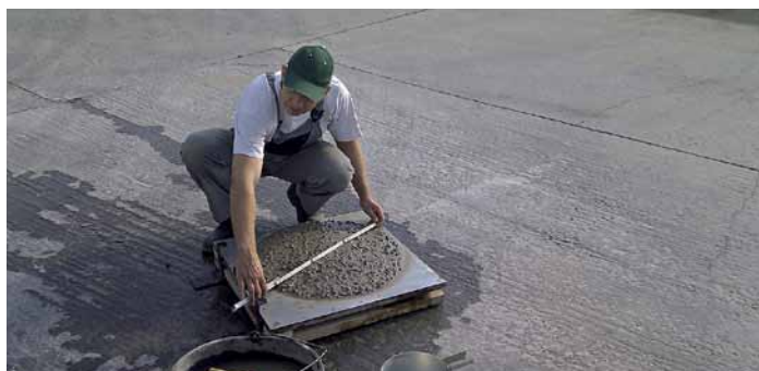
8:40 hod. – v betonárně: STEELCRETE® – zkouška rozlivu na betonárně, stanovení konzistence
