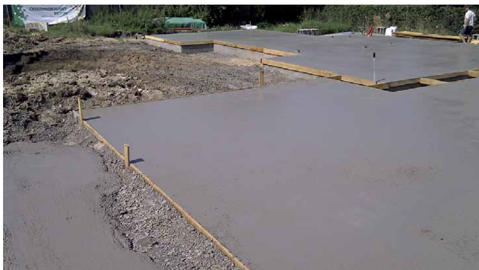
12:00 hod. – na stavbě: Hotová rovná základová deska z vláknobetonu STEELCRETE®
