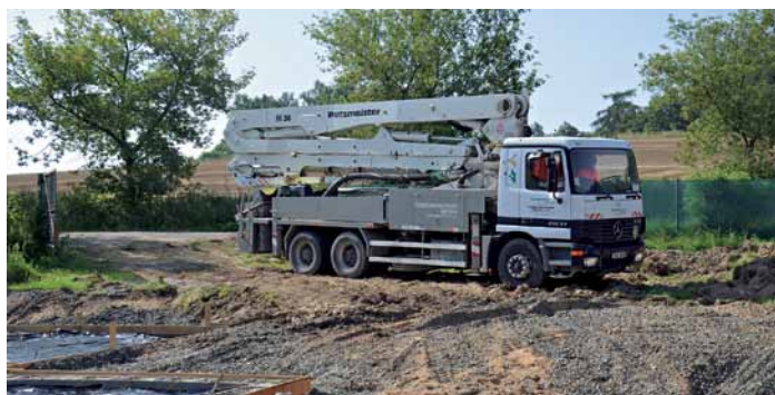
9:30 hod. – na stavbě: Příjezd čerpací techniky na stavbu
