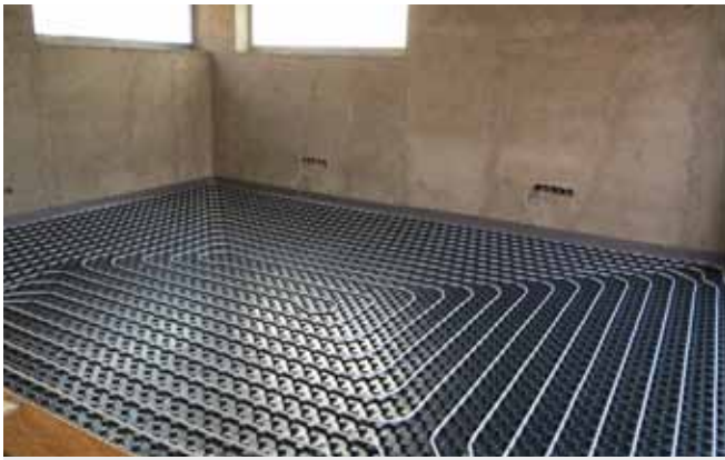
1 Příprava prostor s podlahovým topením k lití potěru
