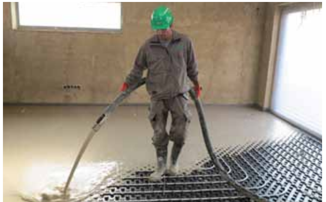
6 Realizace lité podlahy
