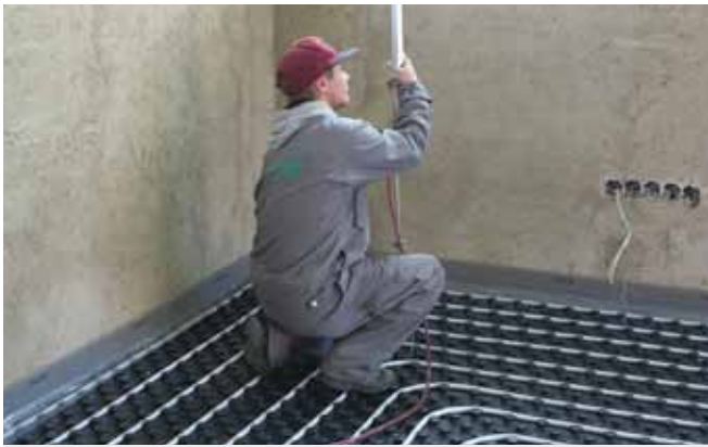
3 Nastavení výšky litého potěru
