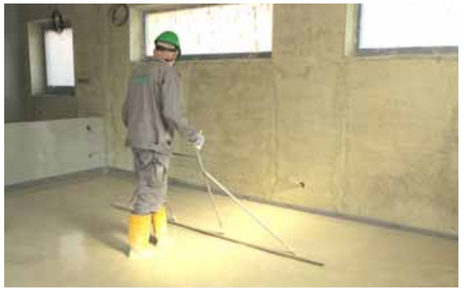
9 Nivelace - konečné urovnání litého potěru
